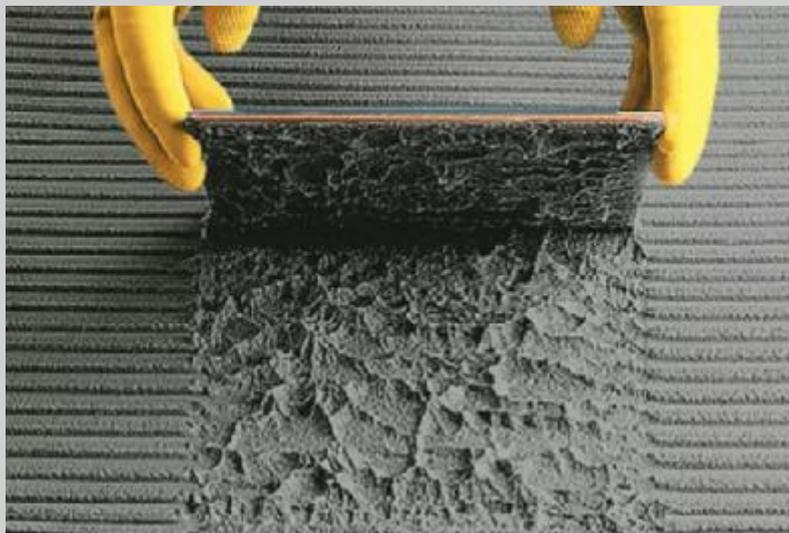
Durante a instalação realize testes de arrancamento para verificar se os cordões de argamassa estão devidamente esmagados.
