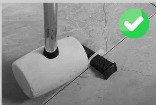
Com o tempo de cura respeitado (72 horas) e as ferramentas em mãos, avance no processo de tirar os niveladores de pisos batendo lateralmente nas peças com o uso do martelo de borracha. Posicione a ferramenta ao lado da peça de piso onde o nivelador está inserido e aplique golpes suaves e precisos até que a peça se solte. Não bater no sentido das cunhas, pois este processo vai danificar tanto o nivelador quanto o piso.
